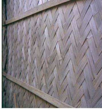
Fig. 20. Bamboo cladding
